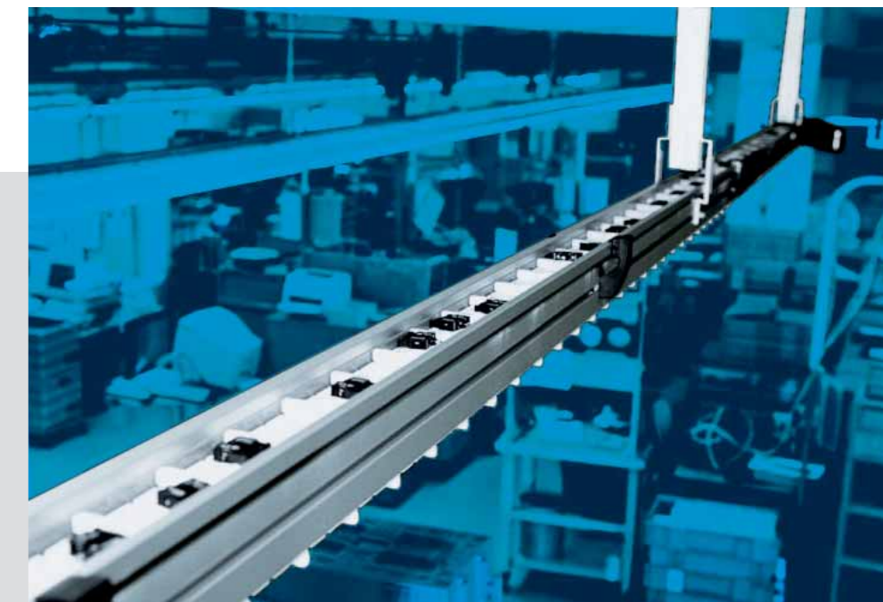
Transport de commutateurs magnétiques sous le plafond du hall
